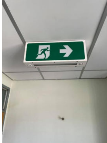
ภาพที่ 19 ภาพป้ายทางหนีไฟ ชั้น 8
