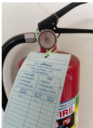
ภาพที่ 26 ภาพป้ายการตรวจสอบถังดับเพลิงชั้น 2
