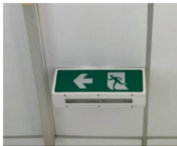
ภาพที่ 18 ภาพป้ายทางหนีไฟ ชั้น 7
