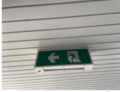
ภาพที่ 15 ภาพป้ายทางหนีไฟ ชั้น 3
