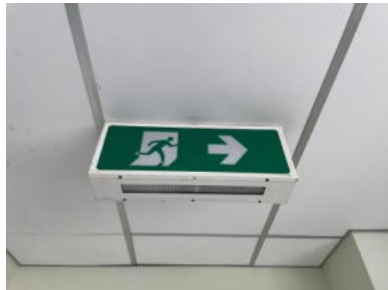
ภาพที่ 14 ภาพป้ายทางหนีไฟ ชั้น 2
