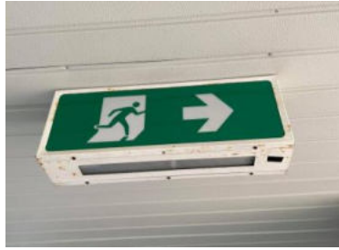
ภาพที่ 16 ภาพป้ายทางหนีไฟ ชั้น 4
